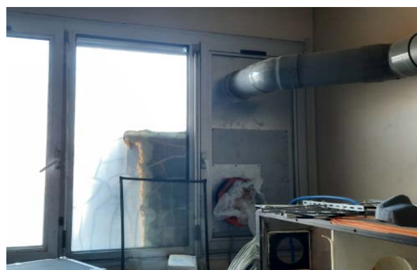
LABO ETAGE Sortie de ventilation via les menuiseries extérieures
